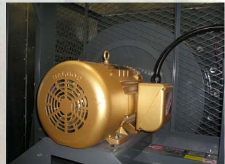
DIRECT DRIVE PLENUM FAN OR FAN ARRAY
